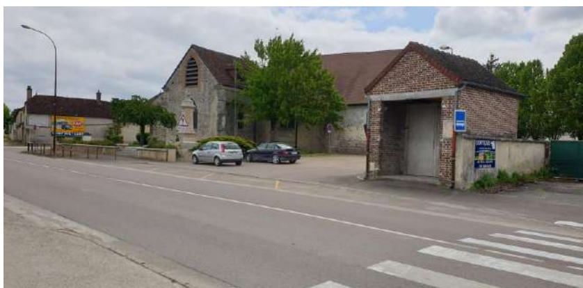
Photo 9. Arrêt de bus le long de la RD671
